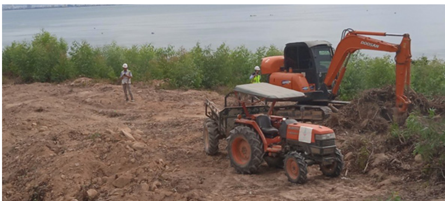
Casa Marina Premium đang trong giai đoạn chuẩn thi công phần hạ tầng
