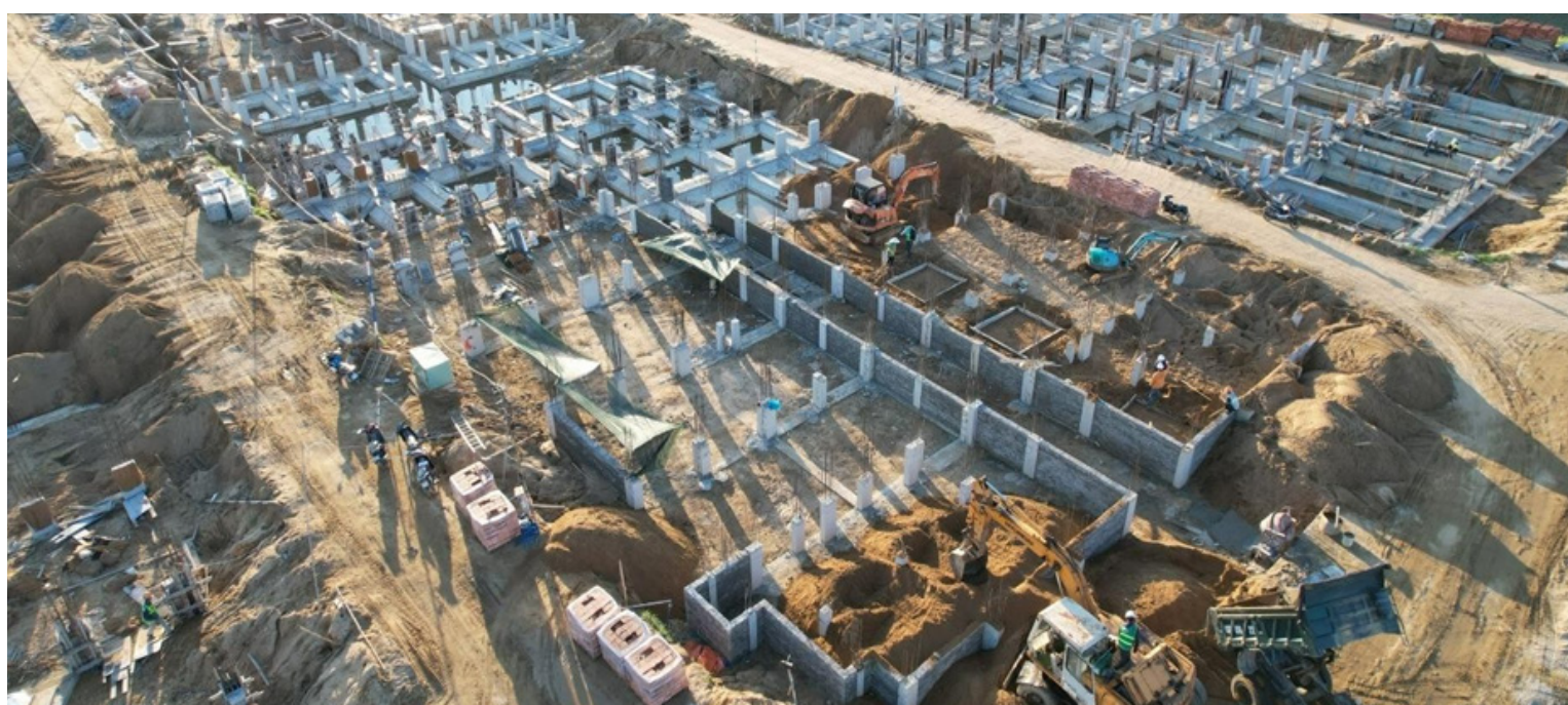
Hoian d'Or đã hoàn tất 99% phần móng của 202 căn Shophouse, sắp tới sẽ thi công phần thân và khu hạ tầng.
